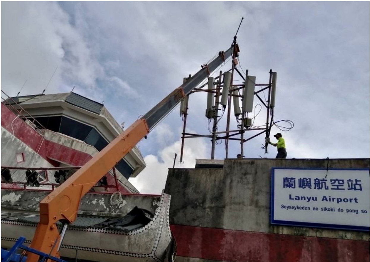
小犬颱風侵台 中華電信全力搶修恢復通信
